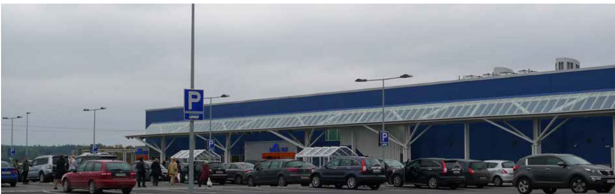
48: Rajaliikenteeseen liittyvä kauppa on tyypillisesti tilaa vaativaa ja liikennettä houkuttelevaa toimintaa. Kuvassa Disas Fish Mustolassa.
